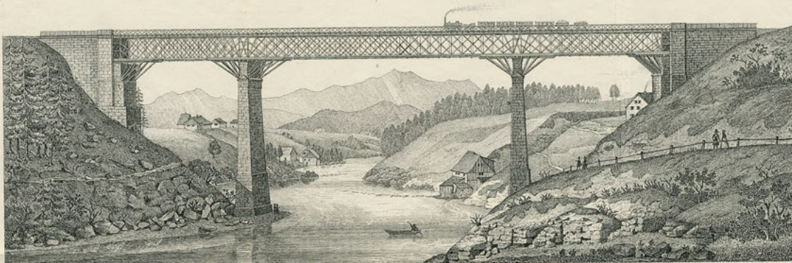
EISENBAHNBRÜCKE BEI KEMPTEN. im Allgäu.
